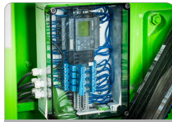
sterowanie do zaworów otrzepujących filtry
